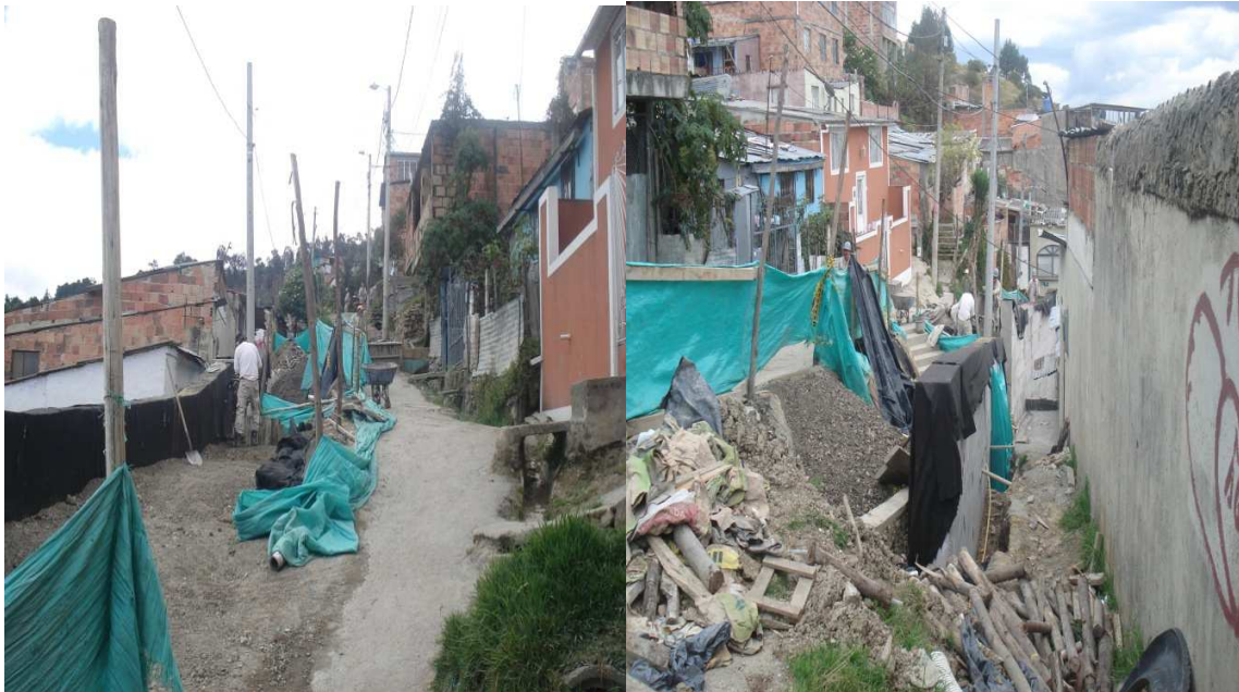
Imagen No. 1 Obras en ejecución sector Cerro Norte. Relleno de muro de contención y conformación de la vía adyacente con fresado
