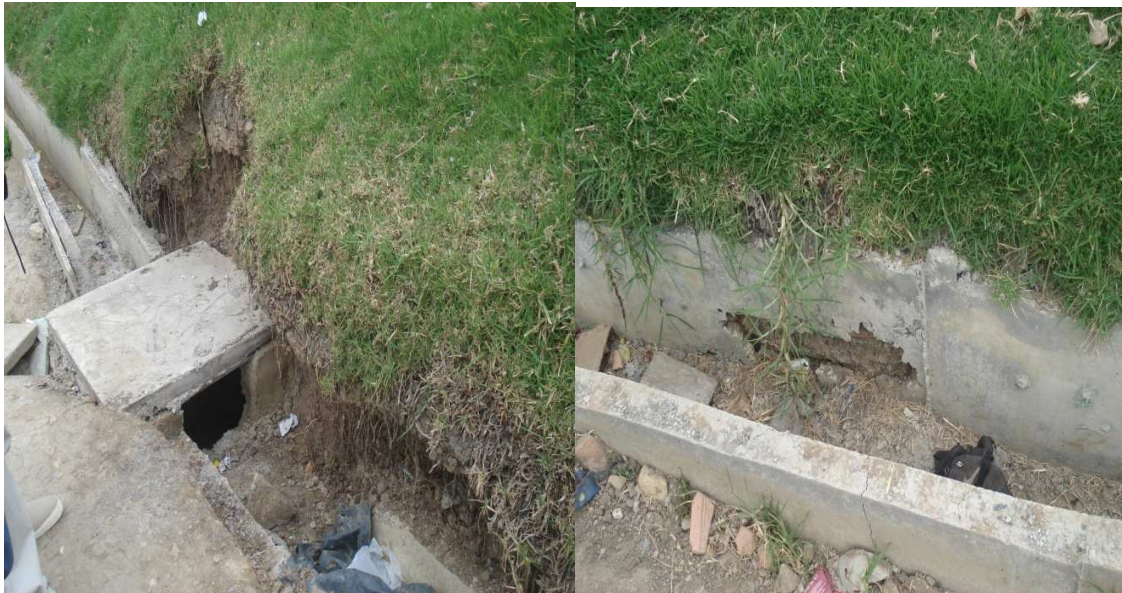
Imagen No.2. Talud mal perfilado, cuneta defectuosa y mal terminada en el sector Sarazota. Localidad Rafael Uribe
